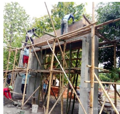
Pembangunan Gerbang untuk Kolam Renang Umbul Tanjung, Wonosari
