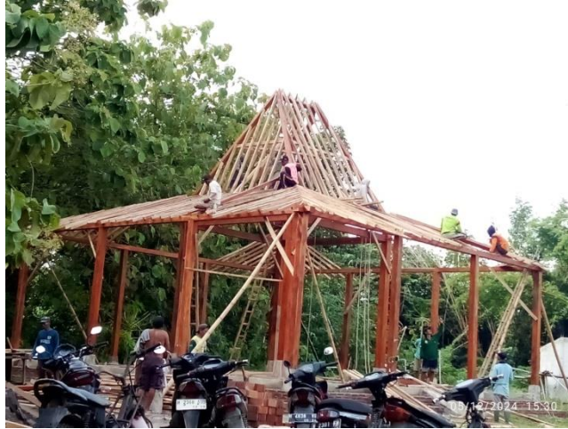
Gambar 7. Pembangunan Pendopo Kolam Renang
