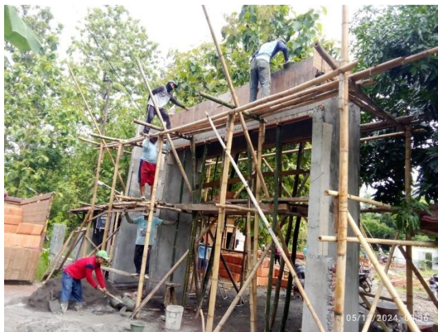
Gambar 8. Pembangunan Gapura Masuk Kolam Renang
