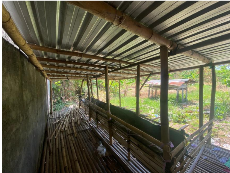
Gambar 10. Pembuatan Kandang Domba Baru Pak Santosa
