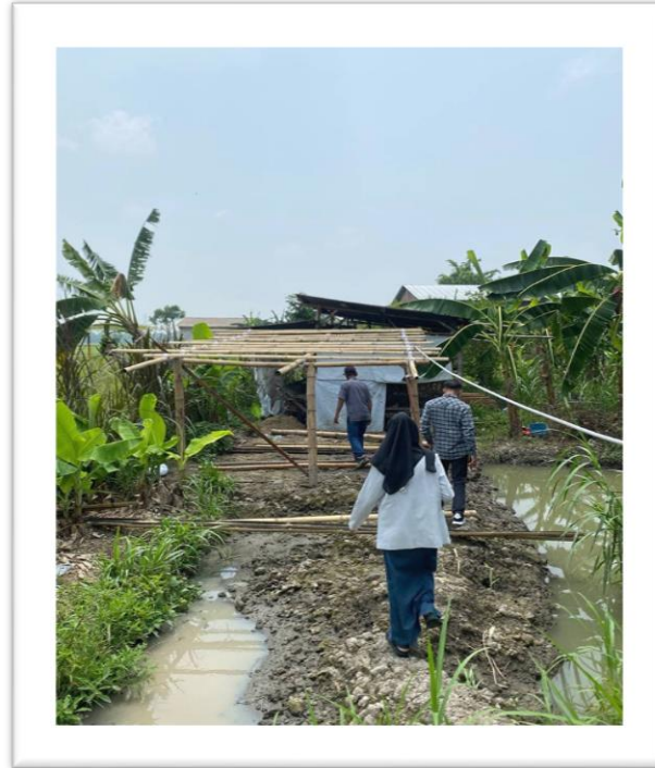
(Pembangunan kandang domba milik usaha bersama)
