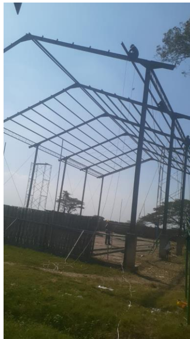
Gambar 2. Proses Pembangunan Lapangan Bola Voly
