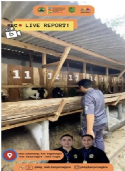
Gambar 58. Renovasi Kandang Kambing
