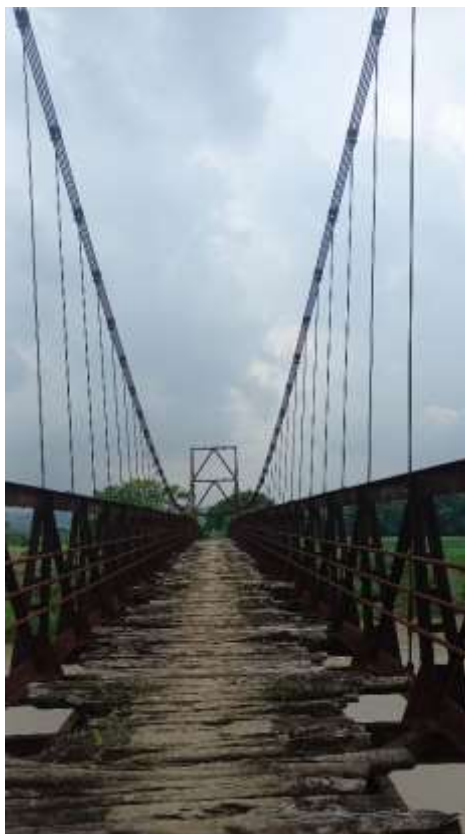
Gambar 2. Jembatan Peninggalan Belanda di Dusun Pidik
